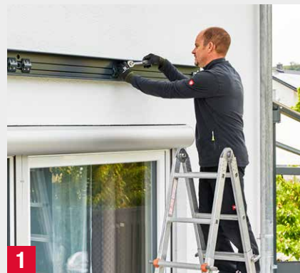
1 Wandanschluss montieren
