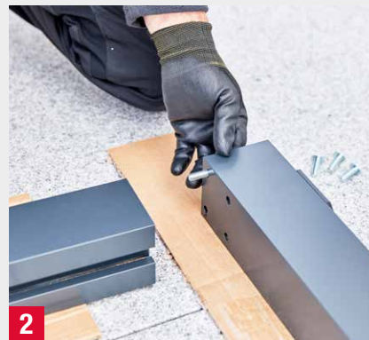
2 Rahmen verbinden (Pfosten/Pfette)
